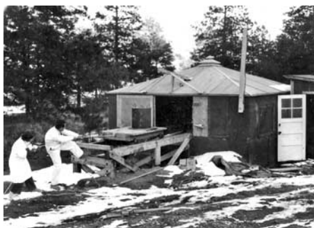
“Remote Handling” at Los Alamos Courtesy of the Los Alamos Historical Society
